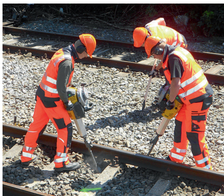
Die Benzinhämmer BH40 und BH55rw sind eigens für Instandhaltungsarbeiten im Gleisbau optimiert.
